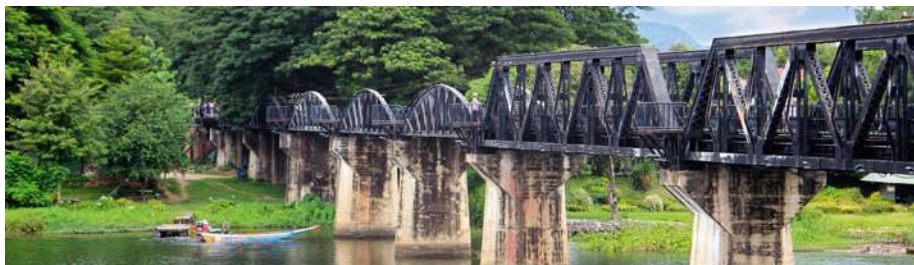
Brücke am River Kwai
