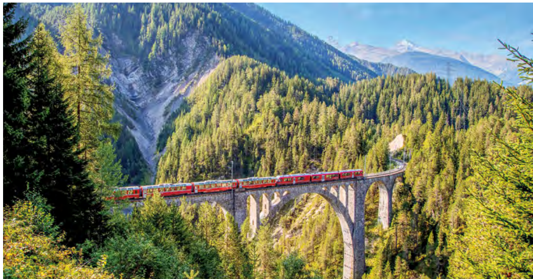
Bernina Express auf dem Wiesener Viadukt
