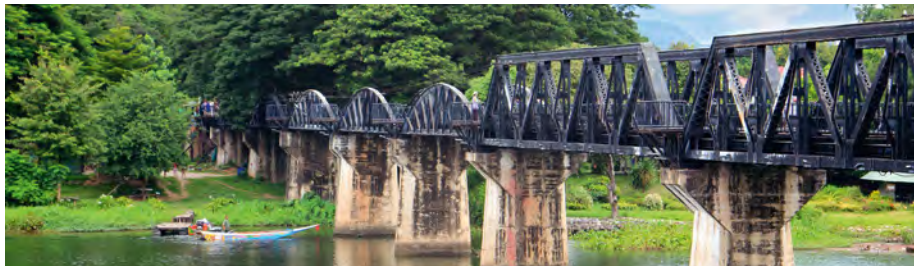
Brücke am River Kwai
